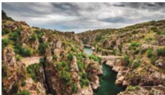
Canal de El Villar
