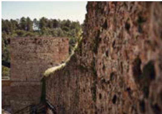
Detalle de la muralla de Buitrago del Lozoya
